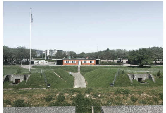
Kig mod Fortmesterboligen og parkeringspladsen.
