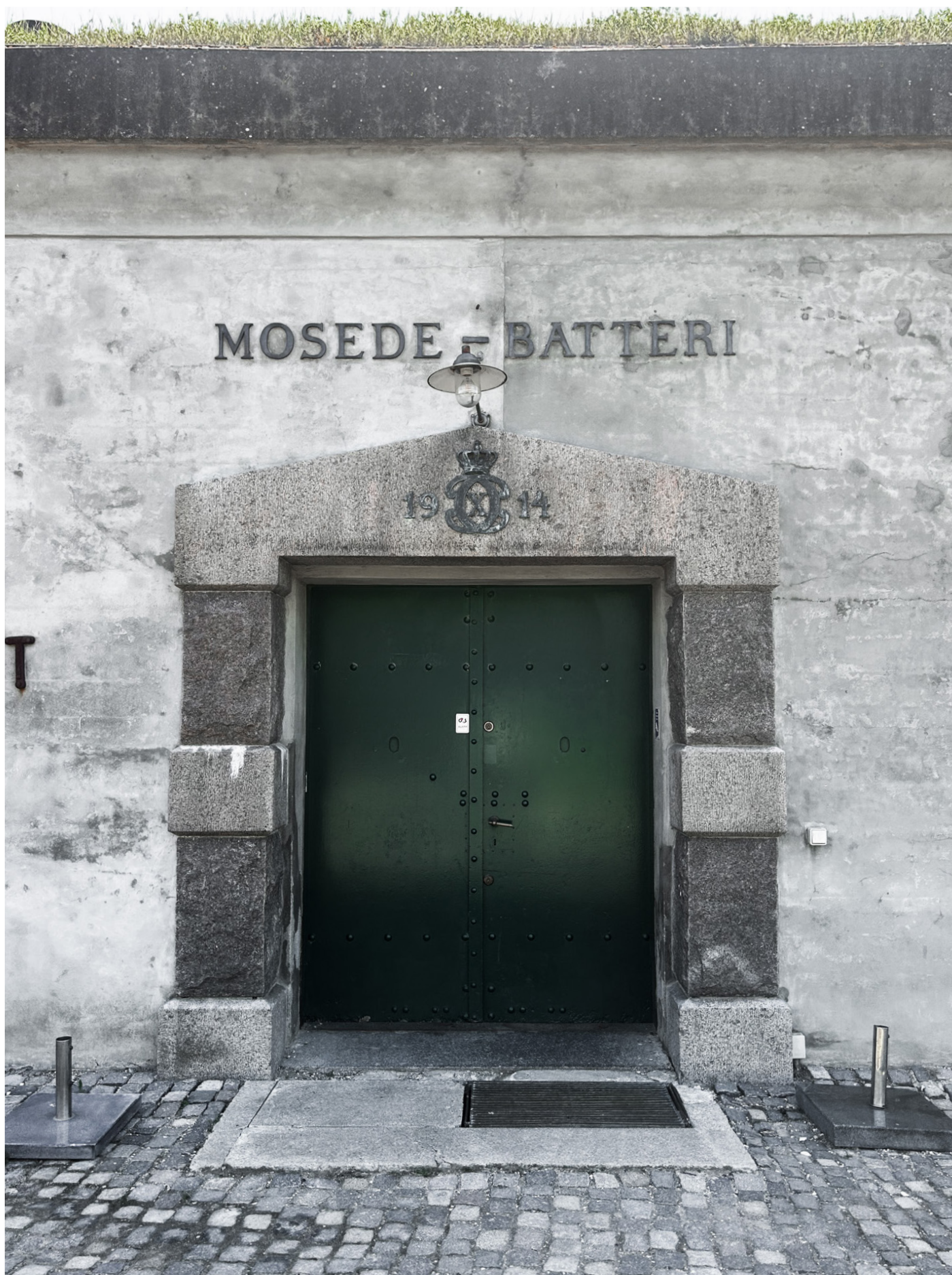
Indgangen til Kasematterne. På bygningen står der Mosede Batteri. Det militære anlæg er dog siden byggeriet blev påbegyndt i 1913 blevet kaldt Mosede Fort.
